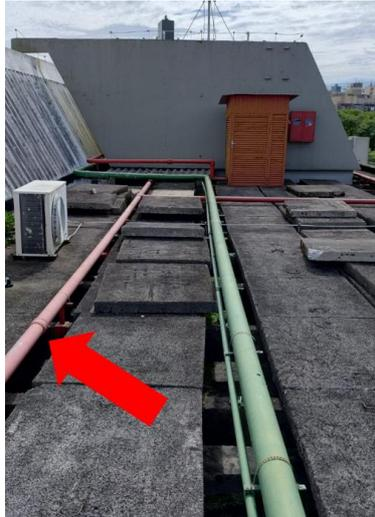
*Figura 5 - Rede de canalização de hidrantes em vermelho e casa de bombas ao fundo*
