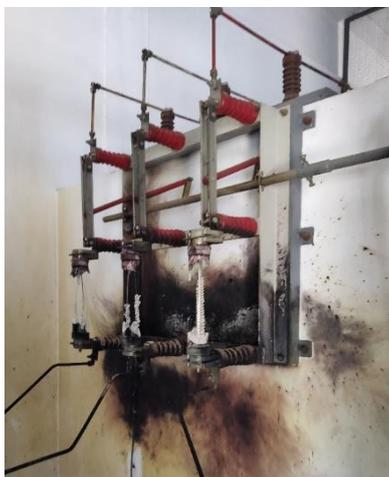
Foto 1: Chave seccionadora do transformador 750 kVA e fusíveis de porcelana quebrados
